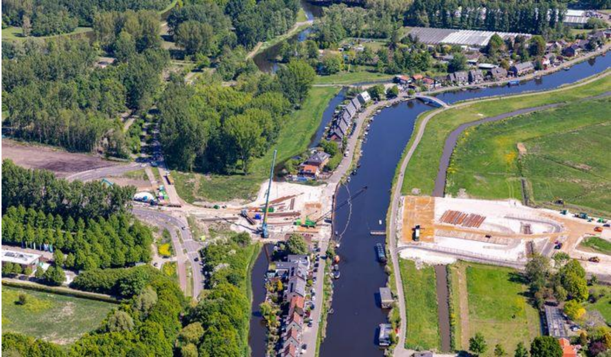
▲ De nieuwe A16 Rotterdam gaat straks bij Ommoord en Bergschenhoek onder de Rotte door. © Rijkswaterstaat
